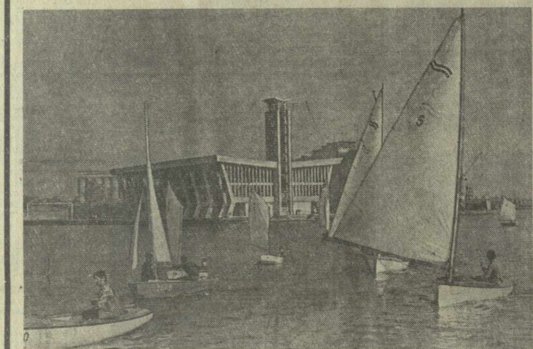
▲ НОВЫЙ МОРСКОЙ ВОКЗАЛ В ПОТИ сдан в эксплуатацию. Оригинальное сооружение из стекла и бетона рассчитано на одновременное обслуживание более трехсот пассажиров. В здании вокзала расположены залы ожидания, кассы, комнаты матери и ребенка, рестораны, бары. Проект морвокзала разработан Одесским институтом Черноморинформ. На снимке: вид на новый морской вокзал в Потии. Фото М. Датквашвили (Фотохроника Грузинформ).
