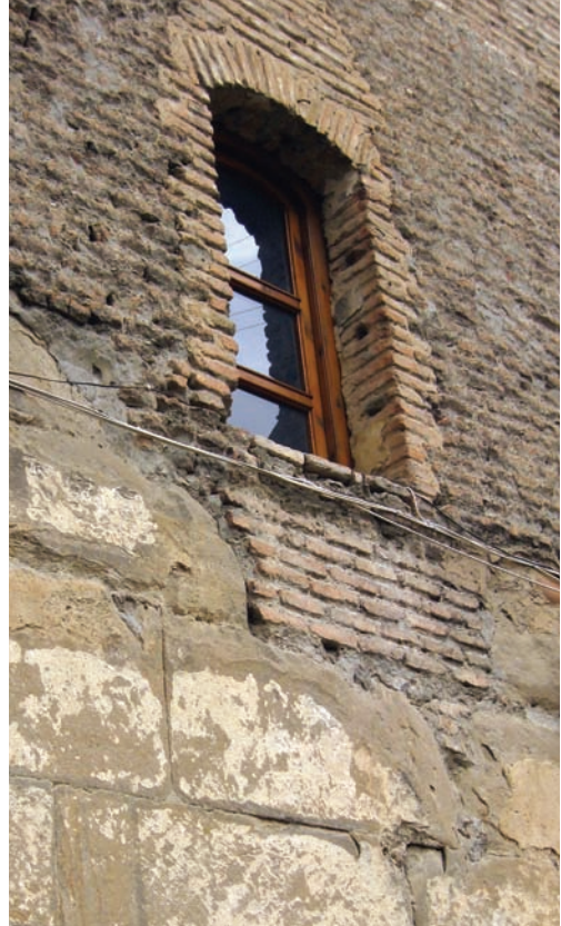
ფასადებზე გაიჩნეა ორი სამშენებლო ფენა: თლილი ქვის ძველი წყობა და აკურით განახლებული ნაწილი
