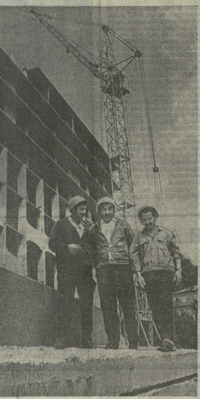
▲ КОМПЛЕКСНАЯ БРИГАДА СУ № 1 треста № 10 «Высотстрой», возглавляемая А. Инсаридзе, работает по злбонискому методу. В эти дни строители взяли повышенные обязательства в честь XXV съезда КПСС.
