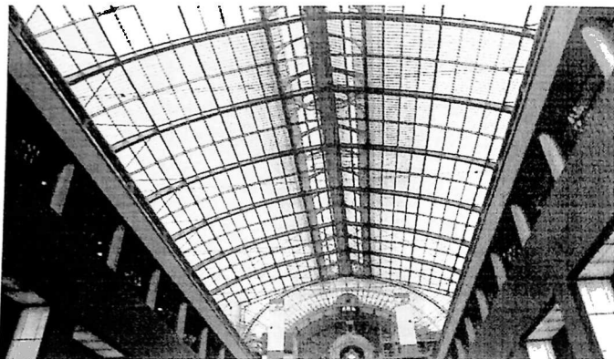
სურ. 1 ანტვერპენი. რკინიგზის სადგური. გადახურვა ლითონის მზიდი ელემენტებით
