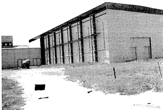
სურ.11. ერთსართულიანი შენობა ლითონის მხიდი კარკასით. განივი პორტალური წარმო (მცხეთის რაიონი)
