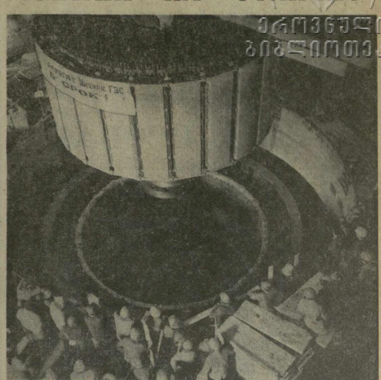
Новую трудовую победу одержали ингурские гидростроители — в подземном здании электростанции в кратер турбины первого агрегата опущен ротор генератора.
