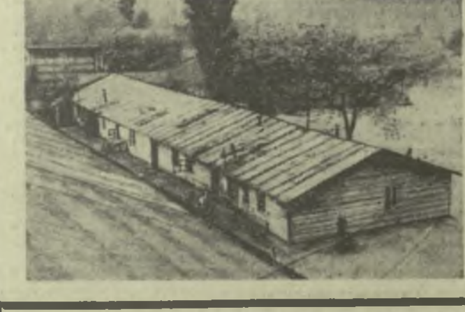
Два снимка. Между ними прошло всего полвека. Срок как будто небольшой, но сейчас даже с трудом верится, что здесь когда-то стояли деревянные наскоро сколоченные хижины. Поднялись вверх кварталы многоэтажных красавцев-домов Кировского станкостроительного. В зеленый наряд оделись улицы.
