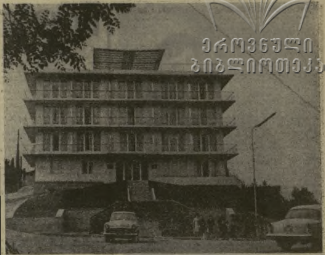
Изю дня в день меняет свой облик районный центр Сигнахи. За последние годы здесь сооружены жилые дома, благоустроены улицы, разбиты скверы. На снимке: здание новой гостиницы. Фото Е. Суэуякишвили.
