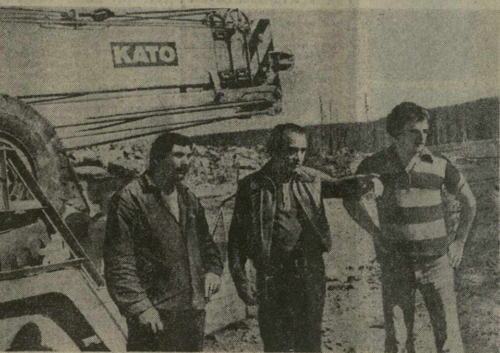
На снимках: сверху — Гив Гамтенадзе приехал на БАМ из Сачхере и работает водителем на самосвале; плотник Шно Метрели из Пицунды, заместитель начальника производственно-технического отдела Омар Гачечиладзе из Кутаиси и каменщик Автандил Адешивили из Вани на строительстве котельной; так выглядит Ния-Грузинская.
