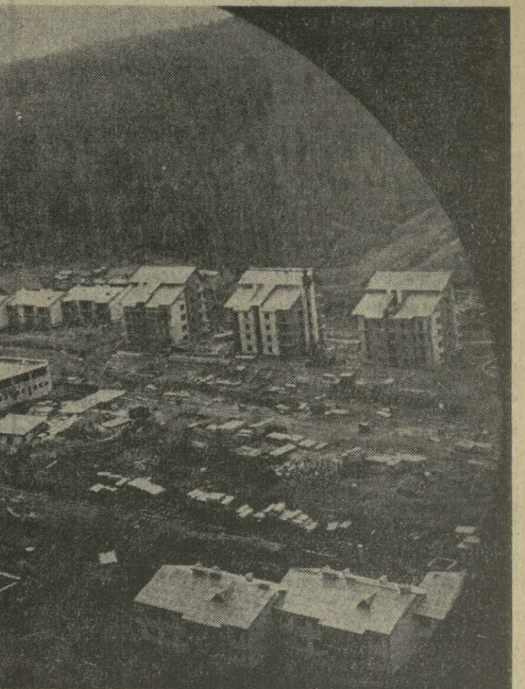
На снимках: сверху — Гив Гамтенадзе приехал на БАМ из Сачхере и работает водителем на самосвале; плотник Шно Метрели из Пицунды, заместитель начальника производственно-технического отдела Омар Гачечиладзе из Кутаиси и каменщик Автандил Адешивили из Вани на строительстве котельной; так выглядит Ния-Грузинская.
