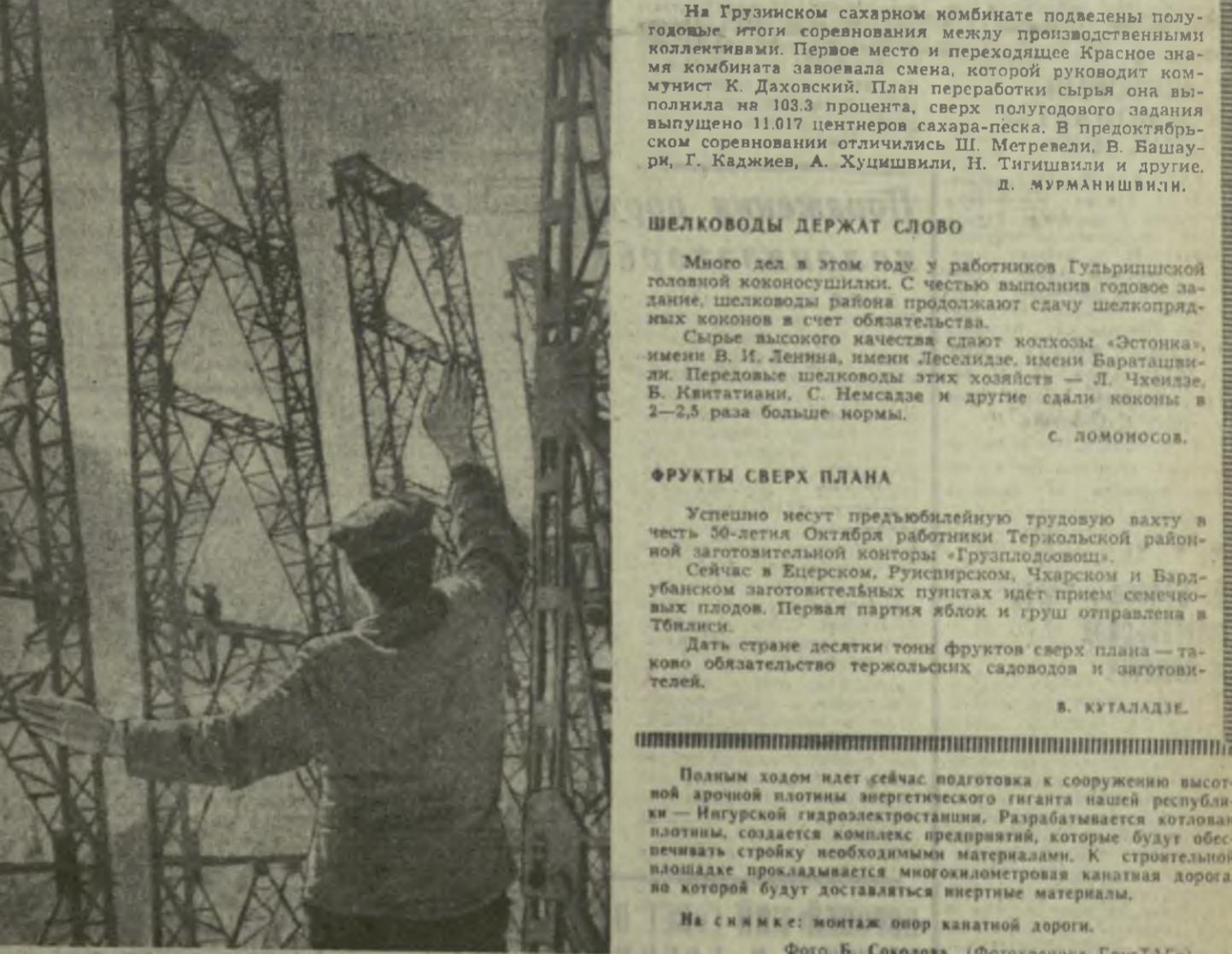
На снимке: монтаж опор канатной дороги. Фото Б. Соколова. (Фотохроника ГрузТАГ).
