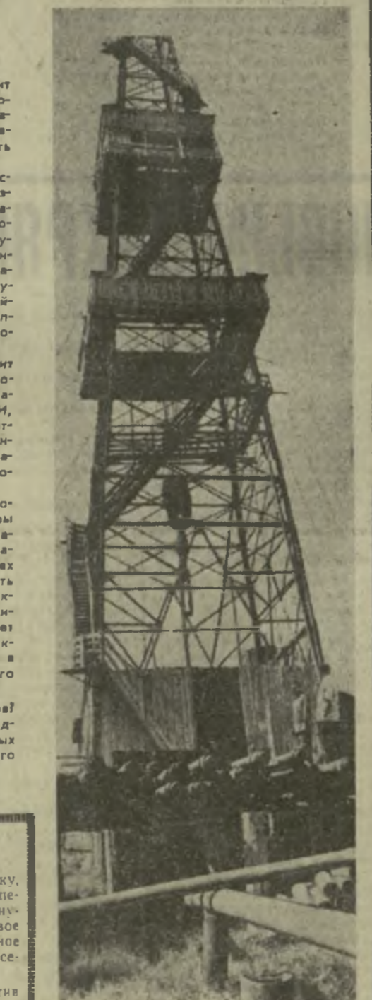
На снимке: буровая № 11. Здесь было открыто новое месторождение голубого топлива.
