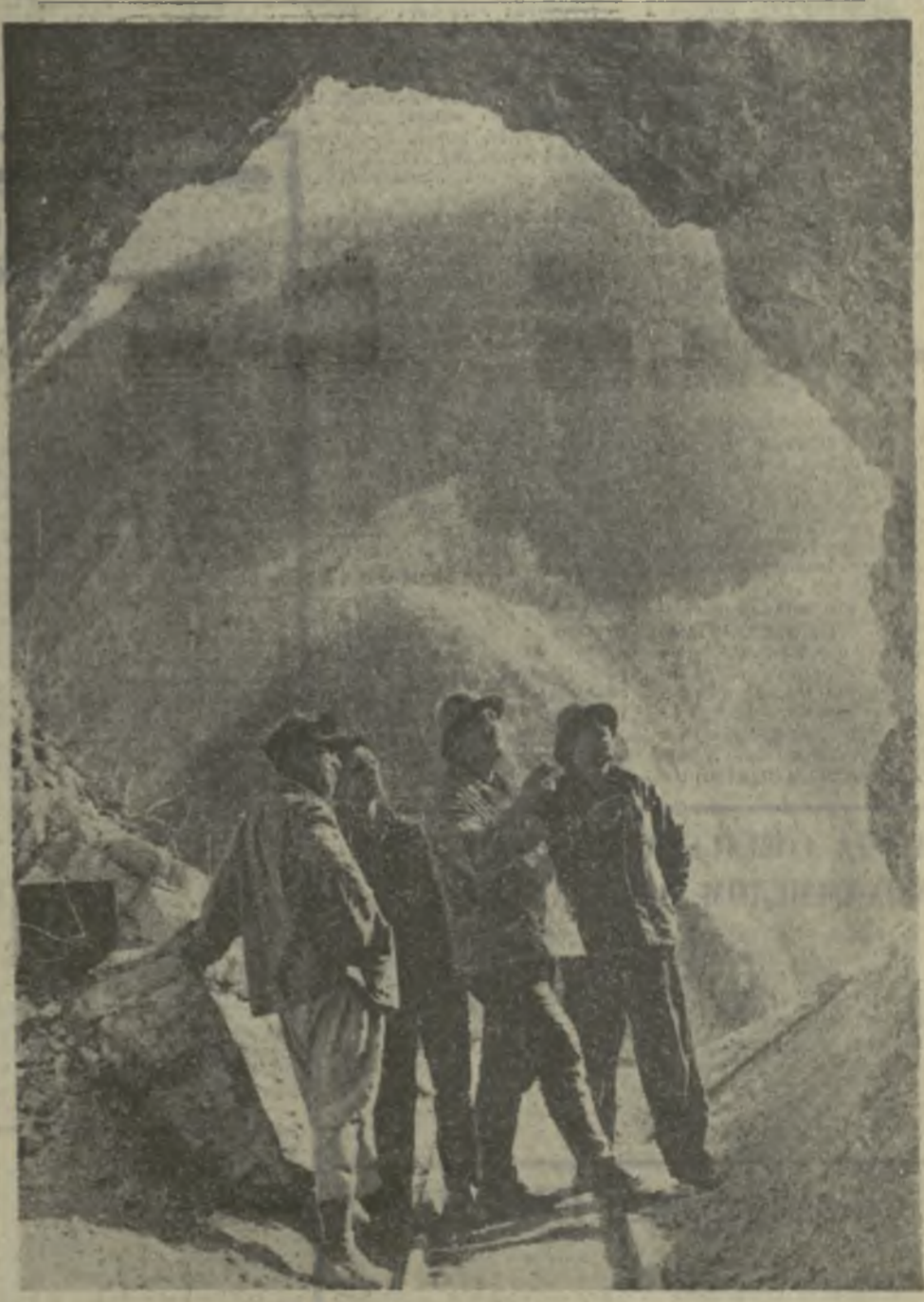
На строительстве энергетического гиганта республики — ИнгуриГЭС кипит работа. Несет трудовую вахту в честь 50-летия Великого Октября гидростроитель изю для в день, из месяца в месяц наращивает темпы. На снимке (слева направо): проходчик А. Сванидзе и Г. Павлов, горный мастер Т. Шарикадзе и проходчик А. Шкунов на одном из участков стройки. Фото Б. Соколова. (Фотохроника ГрузТАГ).
