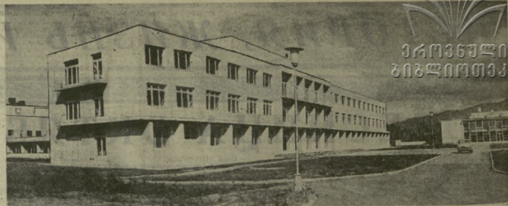
Пройдет еще немного времени, и киностудия «Грузия-фильм» поменяет адрес — переселится в район новостроек столицы нашей республики, на Дигомский массив. Московские архитекторы и проектировщики подготовили Тбилисам замечательный подарок. Оснащенная по последнему слову отечественной техники, новая киностудия сможет выпускать в год более 15 кинофильмов. На снимке: общий вид нового комплекса киностудии «Грузия-фильм».
