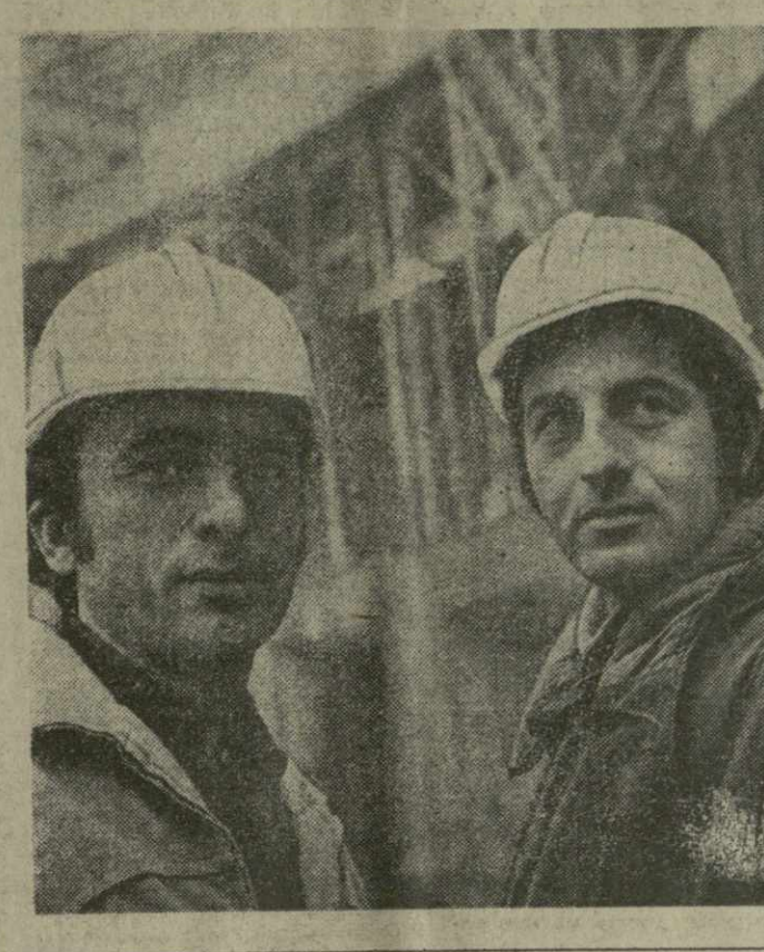
ИнгуриГЭС: на финишной прямой
