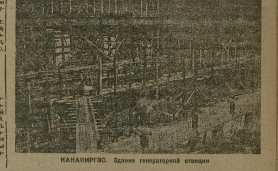
КАНАКИРГЭС. Здание генераторной станции
