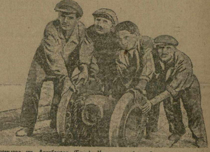
Промысел им. Азизбекова (Баку). Ударники буровой партии мастера Раджабулова тт.: Алмазов Махмуд, Климов Сергей, Хачатуров Аршак и Ковнат Моисей, за протаскиванием предстала для пренератора, устанавливающегося в буровой № 98 на случай сильного газирования.
