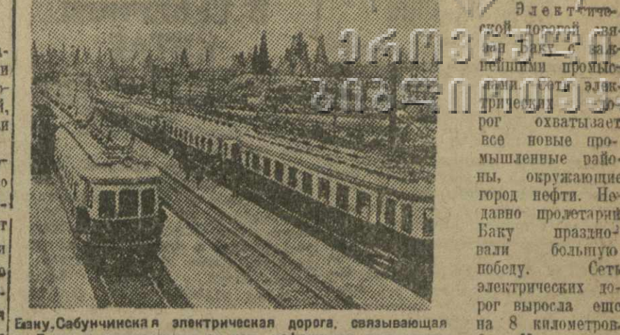
Баку. Сабунчинская электрическая дорога, связывающая Б. Баку с отдаленными от него нефтяными промыслами
