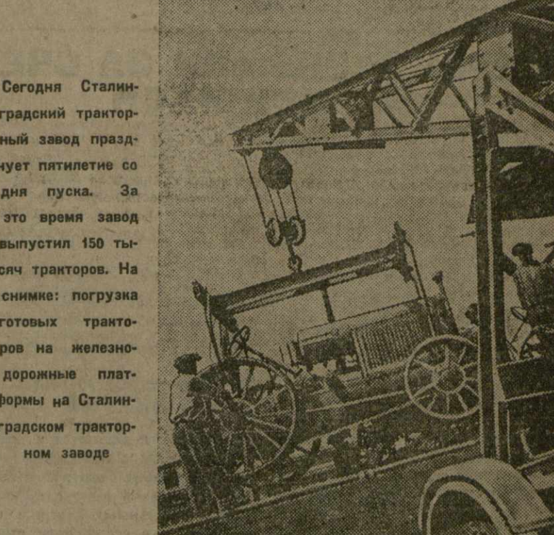
Сегодня Сталинградский тракторный завод празднует пятилетие со дня пуска. За это время завод выпустил 150 тысяч тракторов. На снимке: погрузка готовых тракторов на железнодорожные платформы на Сталинградском тракторном заводе
