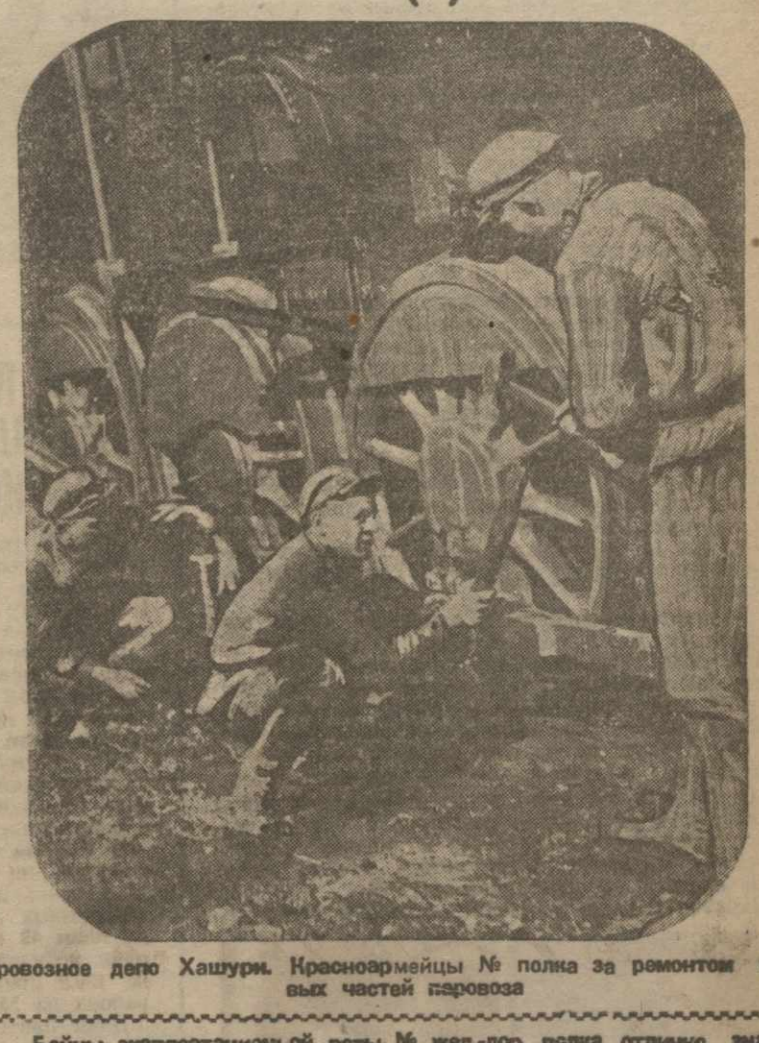
Паровозное депо Хашури. Красноармейцы № полка за ремонтом ходовых частей паровоза
