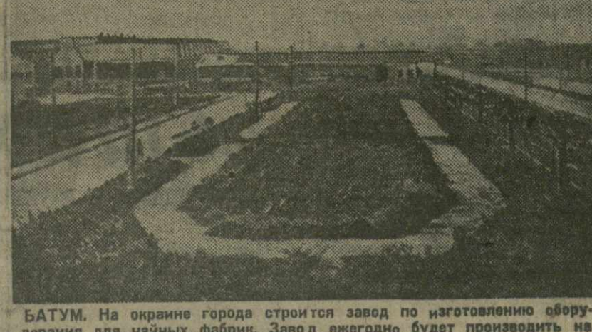
БАТУМ. На окраине города строится завод по изготовлению оборудования для чайных фабрик. Завод ежегодно будет производить на двенадцать миллионов рублей машин. На снимке: олеолиновый двор завода. (Фото К. Айвазян).
