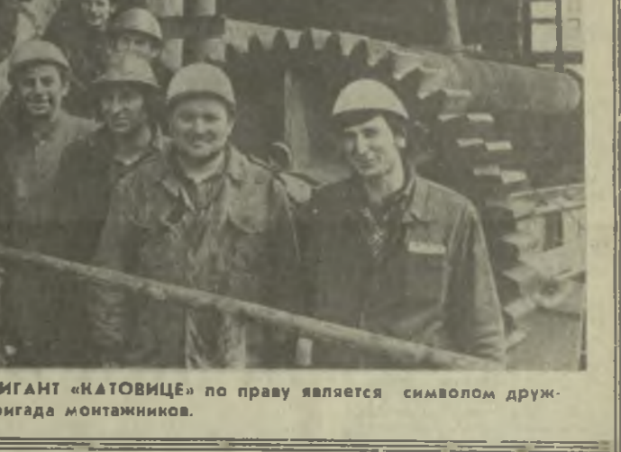
▲ МЕТАЛЛУРГИЧЕСКИЙ ГИГАНТ «ТАТОВИЦЕ» по праву является символом дружбы. На снимке: передовая бригада монтажников.
