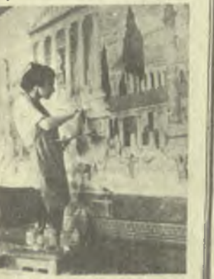
На снимке: ведутся реставрационные работы в школе.
