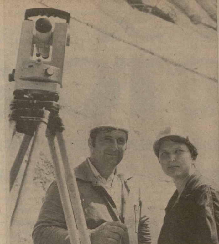
На реке Ингури продолжаются изыскательские работы. Пройдут годы, и здесь, помимо Ингульской и Худонской ГЭС, вырастут еще другие электростанции.
