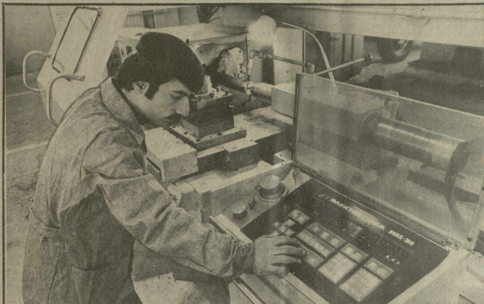
Успешно прошел государственные испытания универсальный токарно-винторезный станок «Электроника-НЦ-31» с операционной системой управления. Конструкция новинки разработана коллективом специального конструкторско-технологического бюро тбилисского производственного объединения «Станкостроитель». Новый станок выгодно отличается от своих предшественников большей производительностью и надежностью в эксплуатации. Скоро начнется серийное производство «Электроника-НЦ-31».
