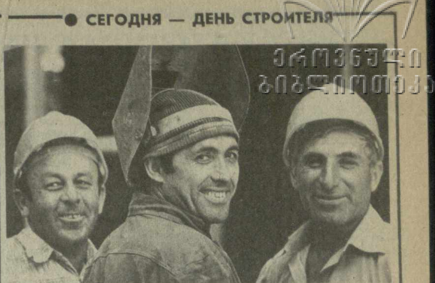
По-ударному трудятся строители СУ-1 треста № 13 Министра Грузинской ССР, которые возводят здание Республиканской научно-технической библиотеки имени Микеладзе по улице Ленина. На снимке: передовые строители Владимир Лазов, Илья Чавчавадзе и Рубен Мчедlishvili.
