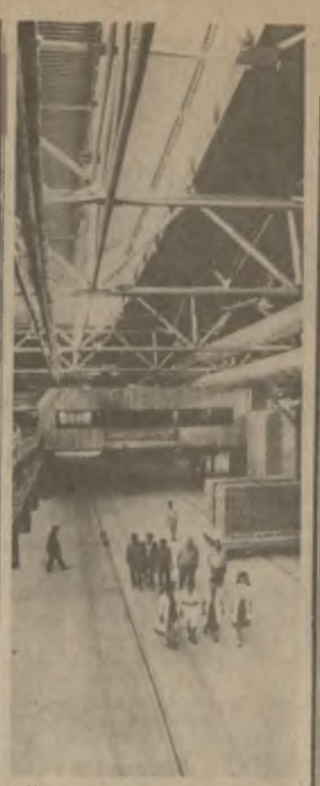
На Метехском комбинате керамических строительных материалов вступил в строй завод керамического кирпича, оснащенный современным высокопроизводительным оборудованием из Болгарии. Технологические линии, станки и машины монтировались с помощью болгарских специалистов.
