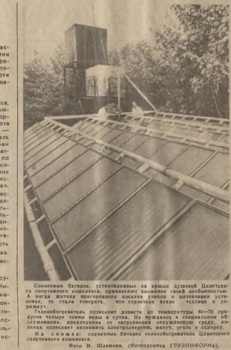
Солнечные батареи, установленные на крыше душевой Цикетского спортивного комплекса, привлекают внимание своей необычностью.
