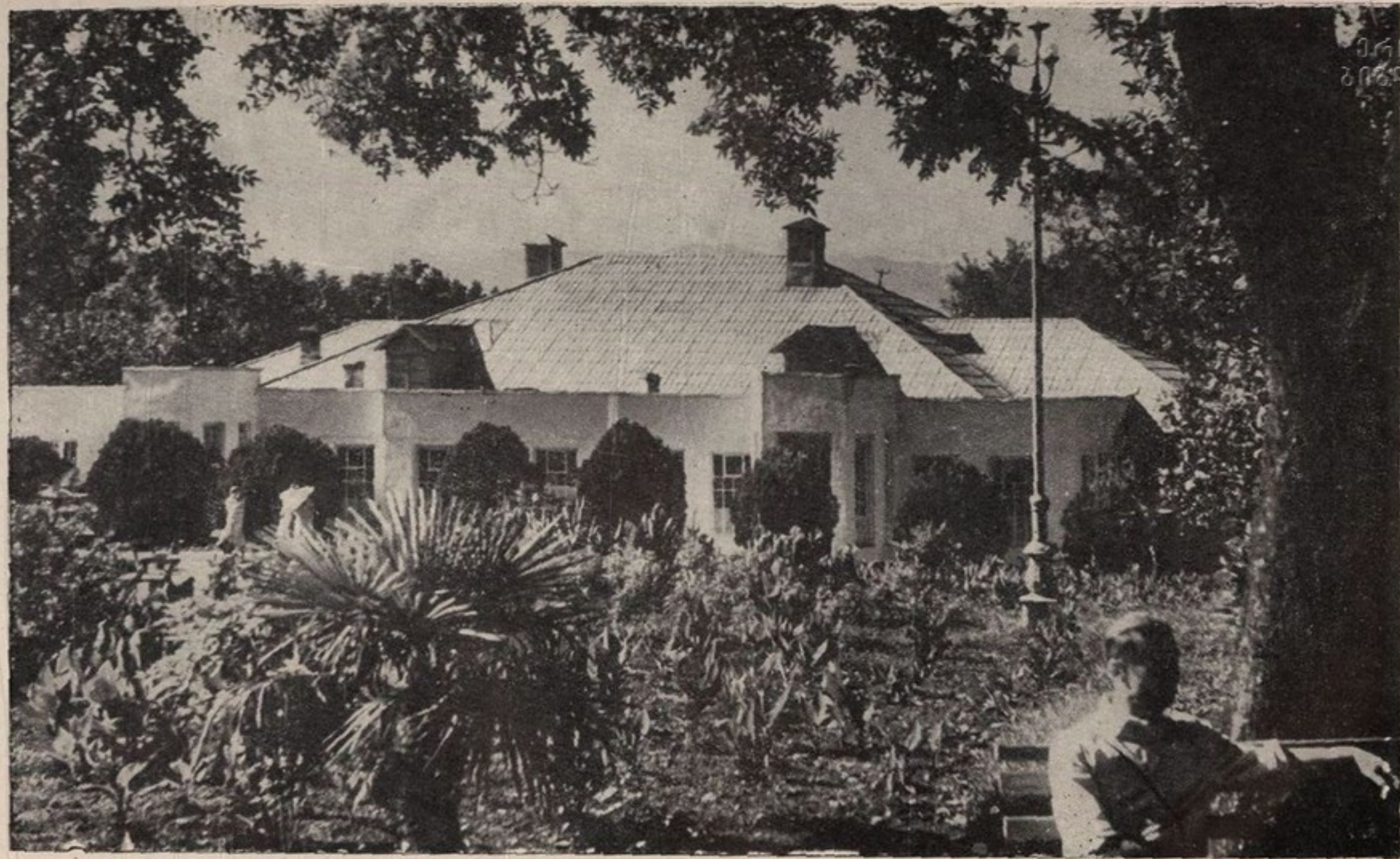
წყალტუბო. № 1 სააბაზანო რეკონსტრუქციამდე.
