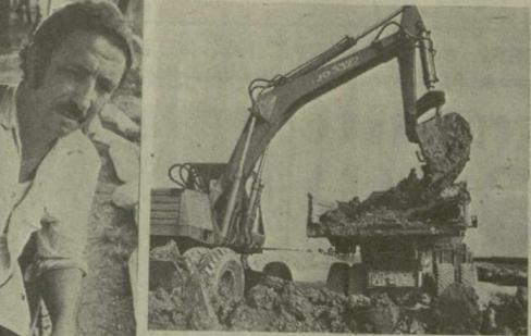
Идет сооружение дороги в объезд г. Очамчир. Она соединит два села — Цагера и Охурей. Работы выполняет дорожно-ремонтно-строительное управление № 17 треста № 3 Минавтодор Грузинской ССР. Начато строительство еще одного важного объекта — объезда города Сухуми. А на центральной трассе ведутся работы по укладке асфальтобетонного покрытия. Возглавляет их мастер Валерий Бенидзе.
