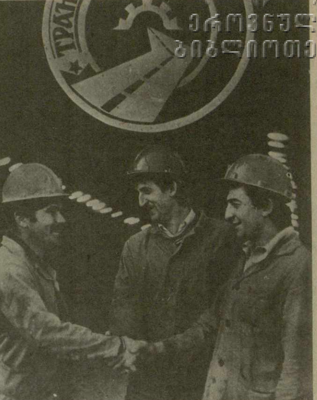
Нарастающими темпами идут работы по строительству второй очереди Транскавказской автомагистрали, с завершением которой она станет асфальтовой и круглогодичной. Упорно трудятся, чтобы приблизить этот день, дорожники из Цхинвали Александр Медоев, мостовики из Рустави Сергей Заболотный и тоннельщики — метростроители из Тбилиси Зубаир Лашки.
