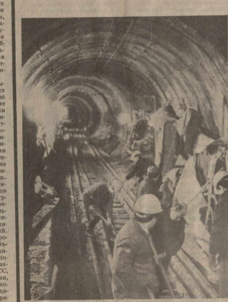
Перед самым Новым годом пробный поезд пройдет по новому участку Тбилисского метро «ТЭБЗ» — «Гураминский» — «Глдани». На помощь метроостроителям тоннельного отряда № 5 «Тблтоннельстрой» пришли бригады из разных городов страны. Все более активно в работу включается население города.
