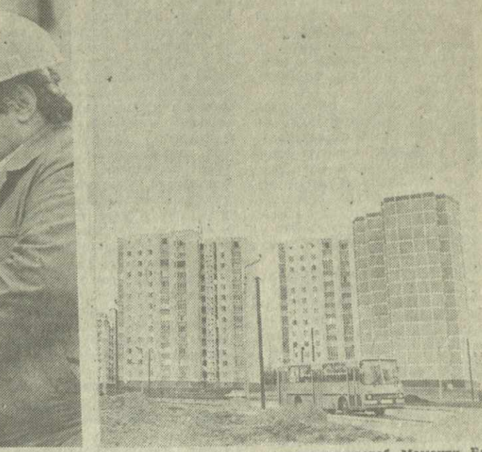
На объектах тбилисские строители — прораб Маманти Бацхалава, бригадир комплексной бригады Бади Лашкина, старший производитель работ Звиадзе Сакелашвили, прораб Тенгиз Пидкбадзе; еще один дом для юнсовцев Варкетили.
