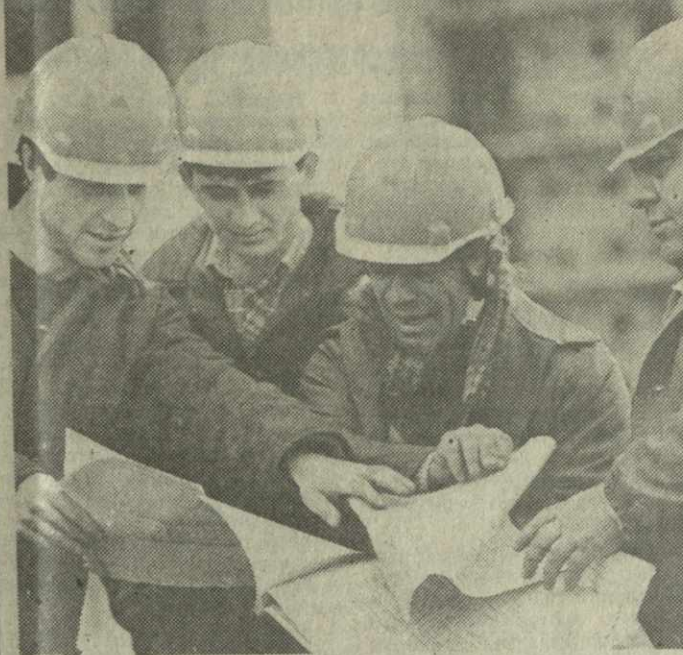
Коллектив домостроительного комбината № 2 в 1989 году стал в эксплуатацию десять жилых домов общей площадью 75,460 квадратных метров. Восемьсот семей тбилисцев отпраздновали в них новоселье.
