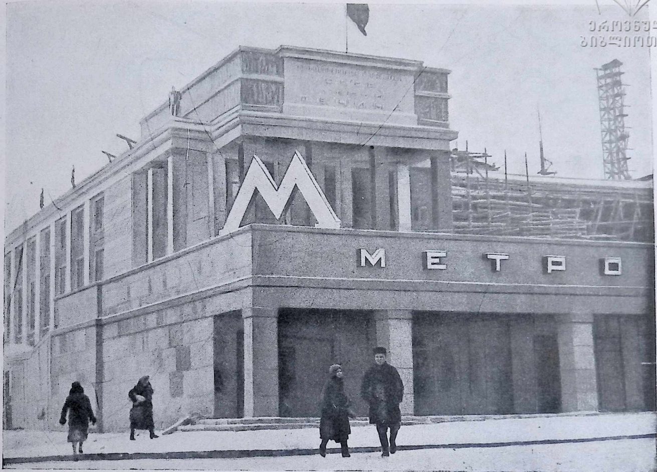
53. Станция УЛИЦА КОМИНТЕРНА. Наземный вестибюль.
