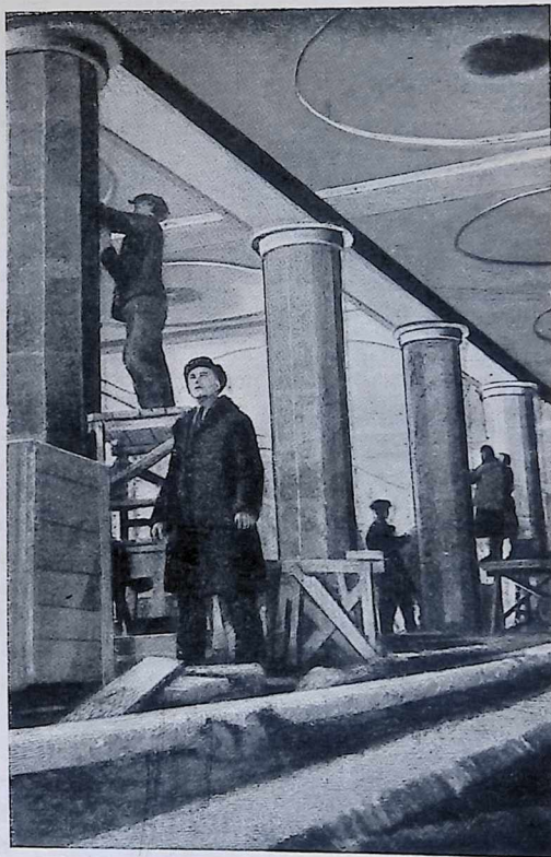
28. Облицовочные работы на станции Красносельская
