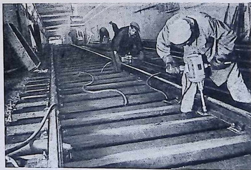
11. Монтажные работы по укладке путей
