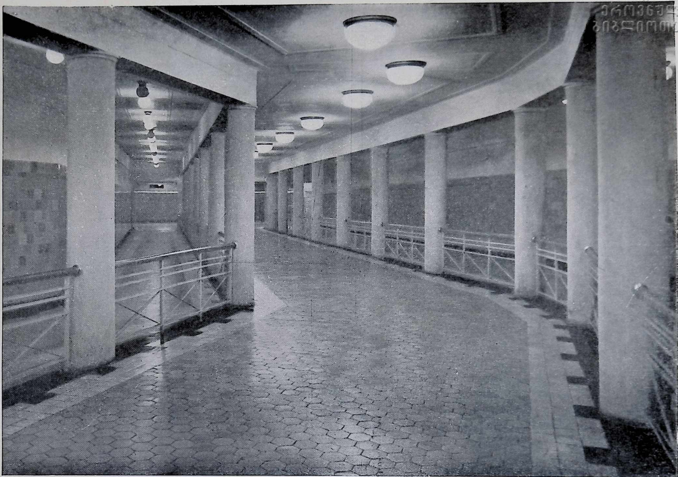
3. Станция СОКОЛЬНИКИ. Коридор, ведущий к перрону. Авторы: арх. Быкова И. А., Таранов Г. И.
