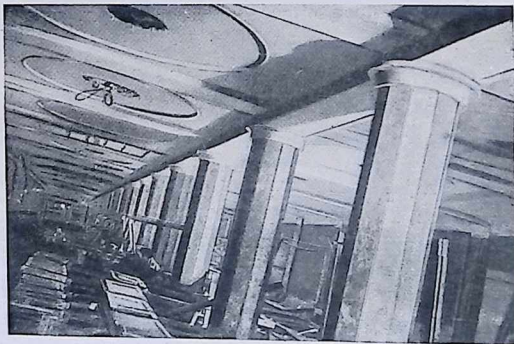
24. Колонны на станции Красносельская
