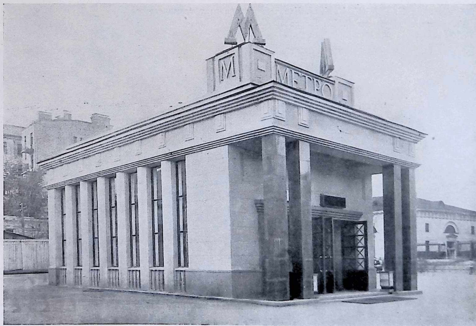
80. Станция ПАРК КУЛЬТУРЫ. Наземный вестибюль на Чудовке № 2. Авторы: арх. Крутиков Г. Т., Попов В. С.
