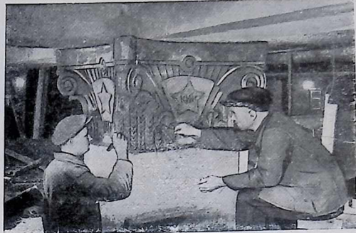
22. Установка капители на станции Комсомольская площадь
