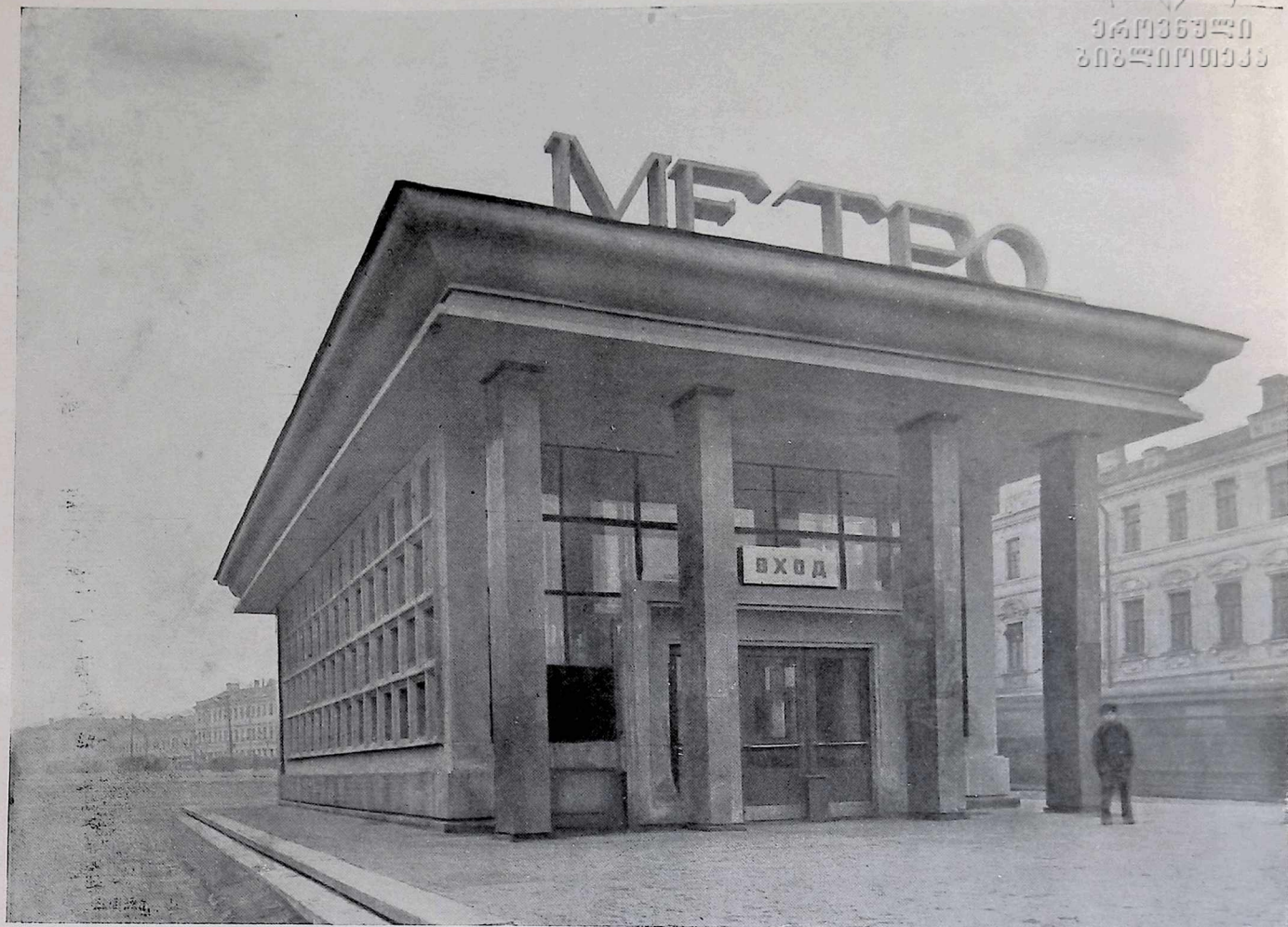
70. Станция СМОЛЕНСКАЯ ПЛОЩАДЬ. Наземный вестибюль. Автор арх. Андриевский С. Г.
