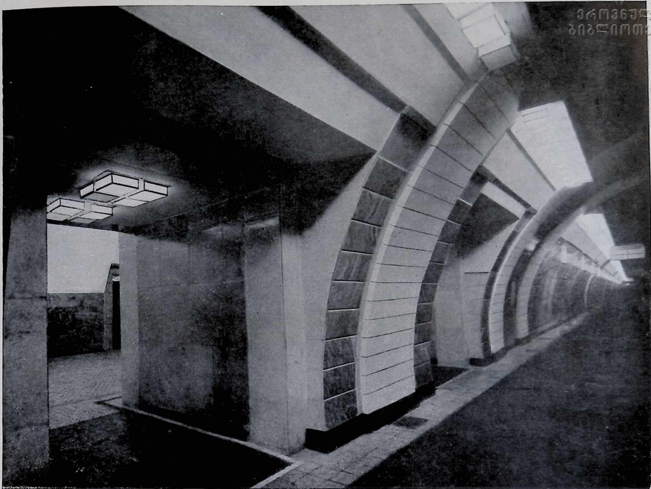
33. Станция ПЛОЩАДЬ ДЗЕРЖИНСКОГО. Боковой тоннель. Автор проф. Ладовский Н. А.
