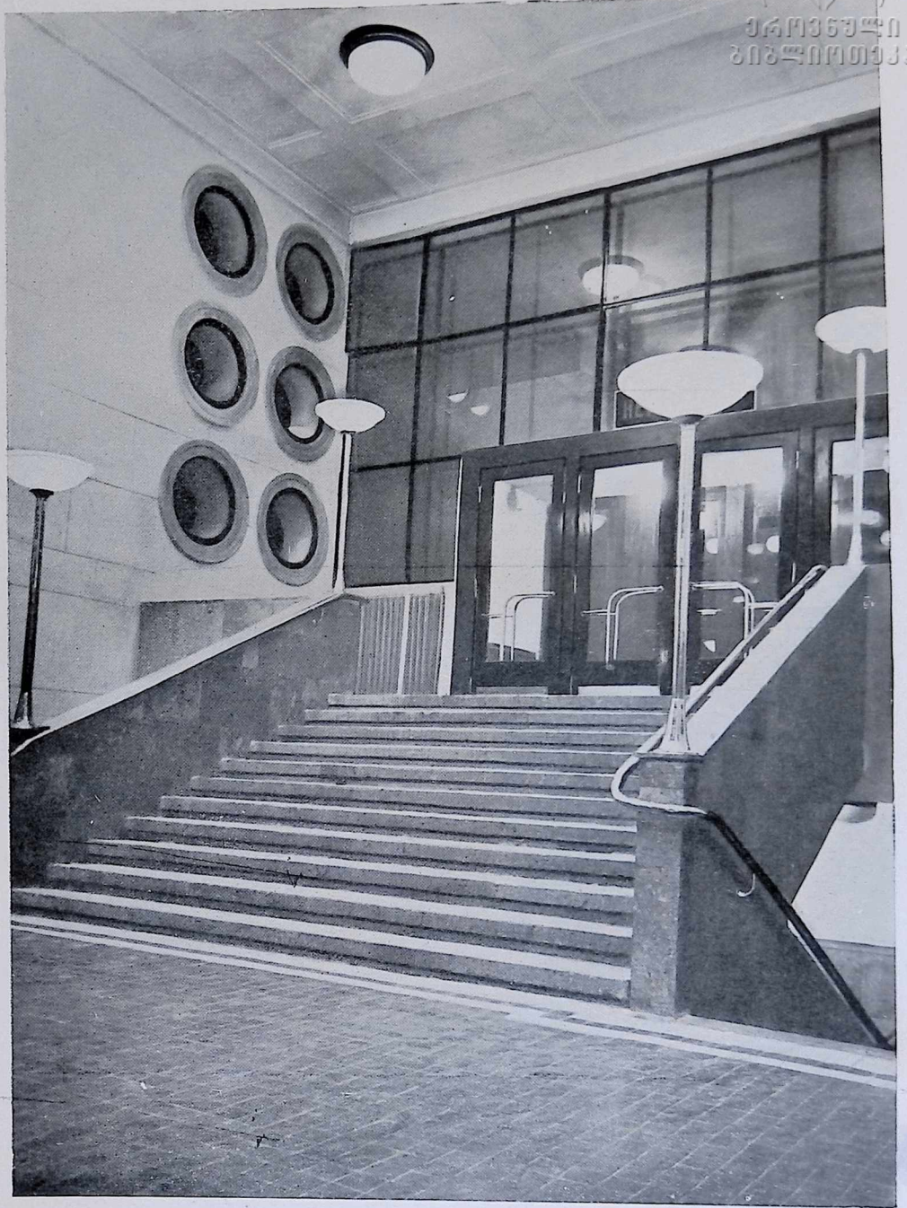
31. Станция КИРОВСКИЕ ВОРОТА. Вестибюль. Автор проф. Колли Н. Я.
