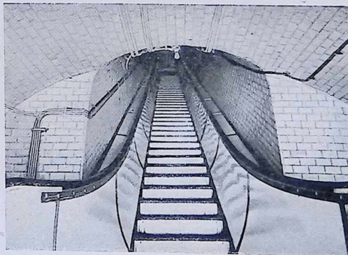
8. Париж. Эскалаторный тоннель (станция Монп) (Монпарназ)
