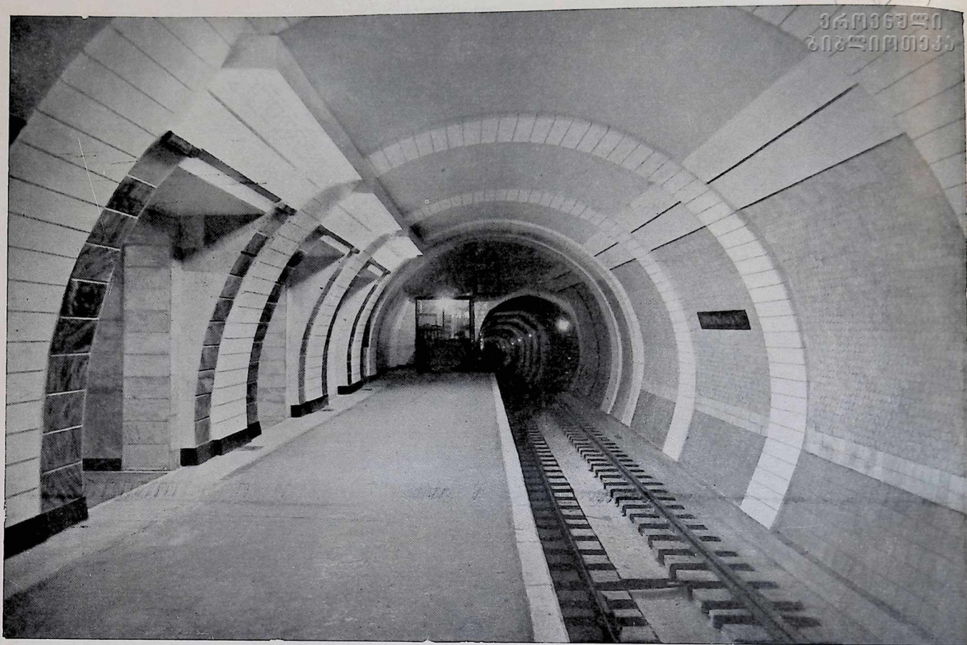
34. Станция ПЛОЩАДЬ ДЗЕРЖИНСКОГО. Боковой тоннель. Автор: проф. Ладовский Н. А.
