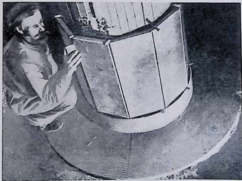
21. Облицовка колонн станции мрамором. Станция Красносельская
