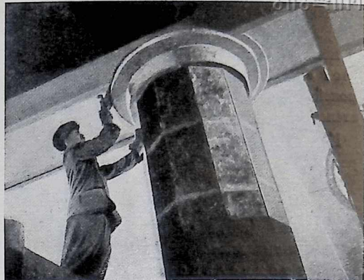
25. Облицовочные работы на станции Красносельская
