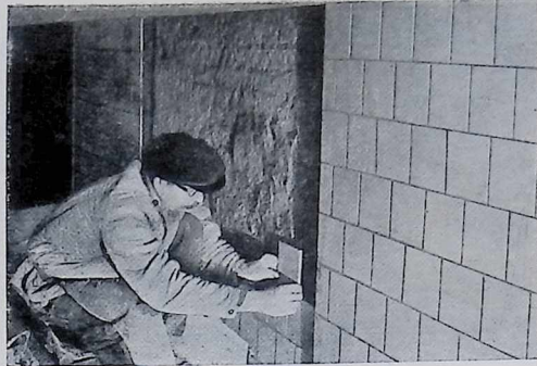
27. Облицовка стены станции Комсомольская площадь глазурованными пантями
