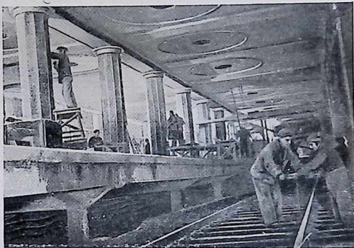
23. Облицовочные работы на станции Красносельская
