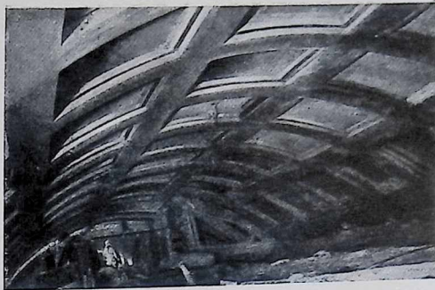
9. Готовый потолок станции Красные ворота
