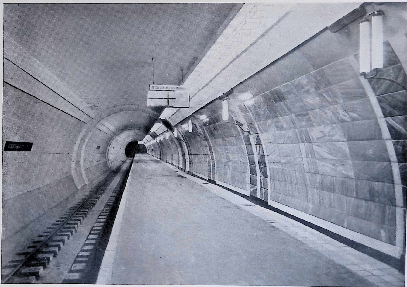
35. Станция ПЛОЩАДЬ ДЗЕРЖИНСКОГО. Боковой тоннель. Автор: проф. Ладовский Н. А.
