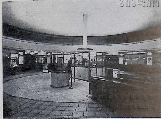
12. Лондон. Вестибюль метро (станция Саутгэт)
