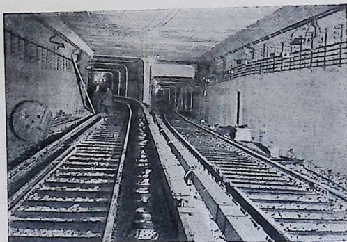
10. Переход двухпутного тоннеля Сокольнического радиуса в однопутные тоннели к станции Комсомольская площадь
