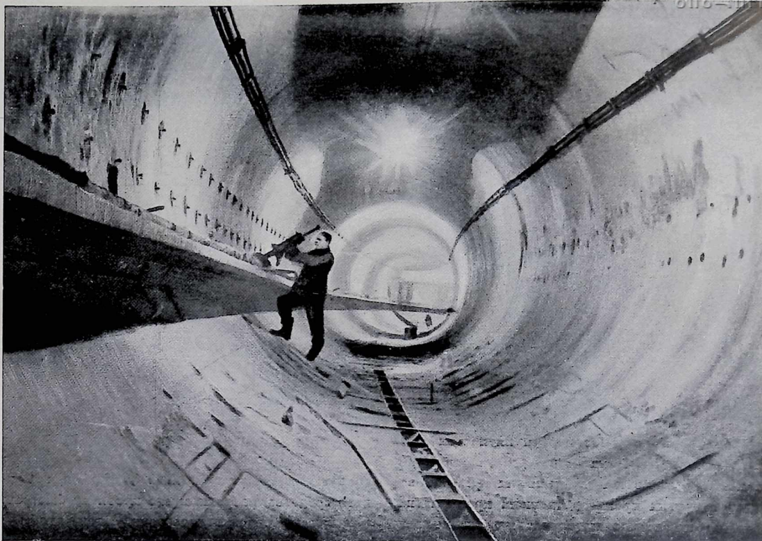
1. Монтажные работы в тоннеле Кировского радиуса
