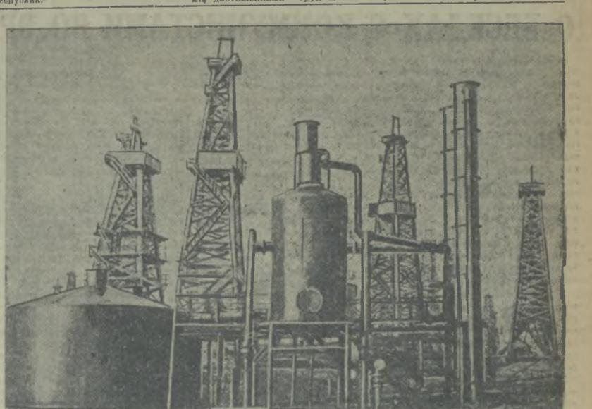
Меринки и система закрытой эксплуатации на промьсла им. Кагановича (Бану). (Фото И. Гомыняцкий).
