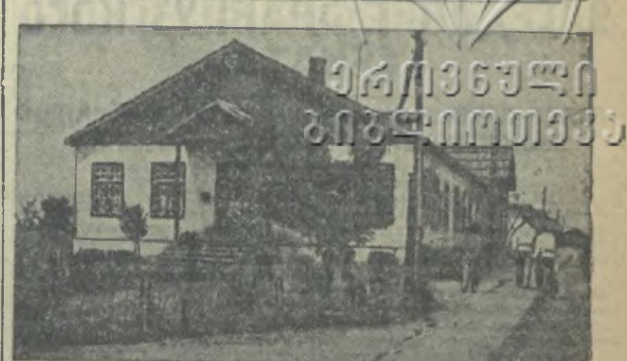
За последние два года в Наразенином чайном совхозе треста «Чай-Грузия» проведена большая работа по благоустройству. На снимке: Новые дома для рабочих совхоза. (Фото В. Полякова).
