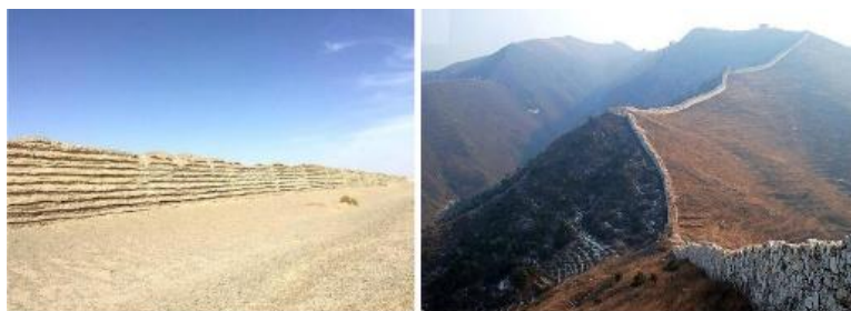
სურ.24. ჩინეთის დიდი კედლის ფრაგმენტები, აგებულია (ა) დატკეპნილი თიხისგან და (ბ) ქვისგან 59
