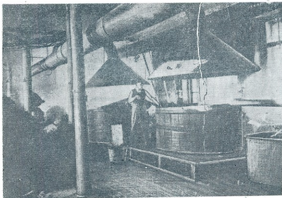
ნახ. 1. ორთქლის დასაქერად სამღებრო რაოდენობის ზემოთ დადგმული ე. წ. „ქოლგები“ (ა). სადგომში ჰაერის ნისლიდან დადგმული ნილგლები (ბ), რომლებიც ჰაერს აწვდიან ქვედა ზონაში.
