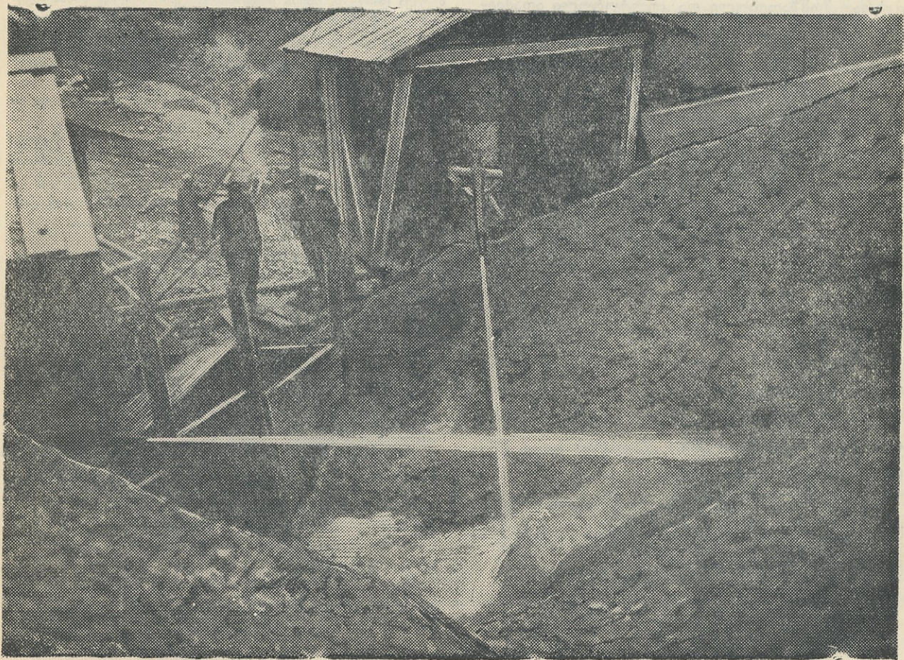
ტყიბული. სტალინის სახელობის შახტი. გამომუშავებული სივრცის ამოვსება ჰიდრომექანიზაციის საშუალებით.
