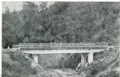
ნახ. 2. მსუბუქი ბეტონის ხიდი. ავტორები — მ. აიუ-ბოვიჩი და მ. კანდელაკი
