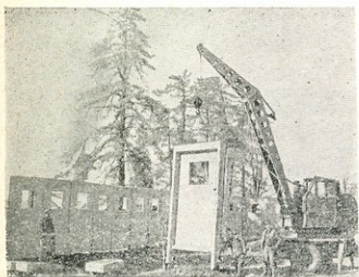
ნახ. 2. ტრაქტორების გარეშის შენობის მონტაჟი ქ. მახარაძეში რკინაგზის პანელბოიში ედლებიდან
