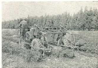
ნახ. 1. სამთო თვითმავალი შსი „სმ-24“ ჩაის პლანტაციის რეკონსტრუქციის კულტივაციის დროს
