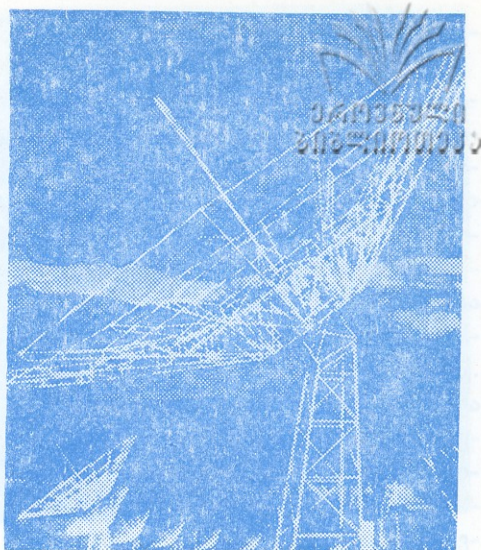
წრიული რადიოტელესკოპი 96 პარაბოლური ტიპის ანტენით (თითოეული ანტენის პარაბოლოიდის დიამეტრია 12 მ). ანტენები დადგმულია წრეზე, რომლის დიამეტრია 3 კმ (ავსტრალია, 1967 წ.)
